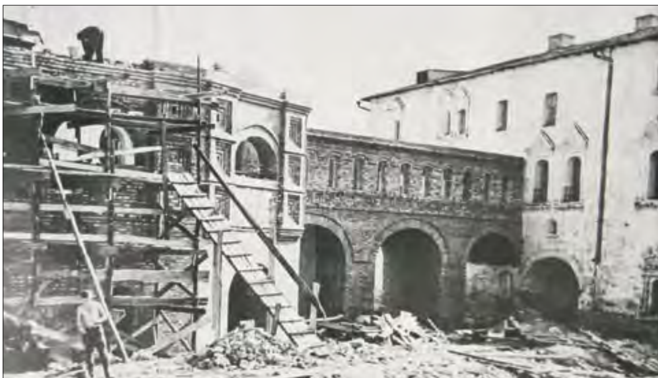
Восстановление крыльца соборной колокольни и галереи-перехода XVII в. Суздальский кремль, 1950-е гг.
