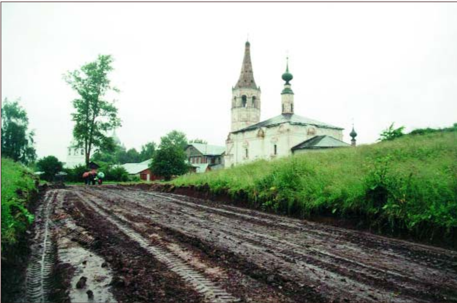
Строительство дороги у Никольской церкви. Нарушен культурный слой крепостных укреплений Кремля XI — XII вв.
