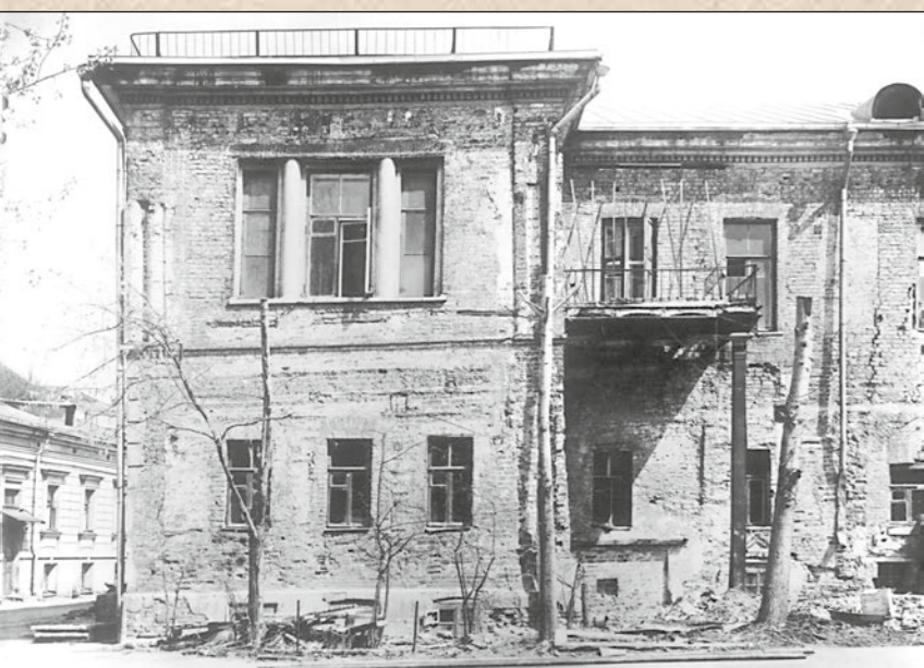
Дворовый (западный) фасад до реставрации...
