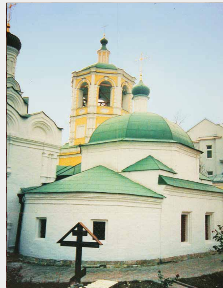
Церковь Успения Богородицы в Путинках. 1670-е гг., 1-я треть XVIII в. До реставрации (вверху) и после реставрации (внизу)
