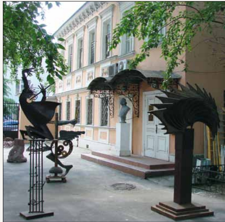
Московский дом скульптора, 1-й Спасоналивковский переулок. Памятник архитектуры. Городская усадьба П.Г. Вяземского. Сер. XVIII–XIX вв.
