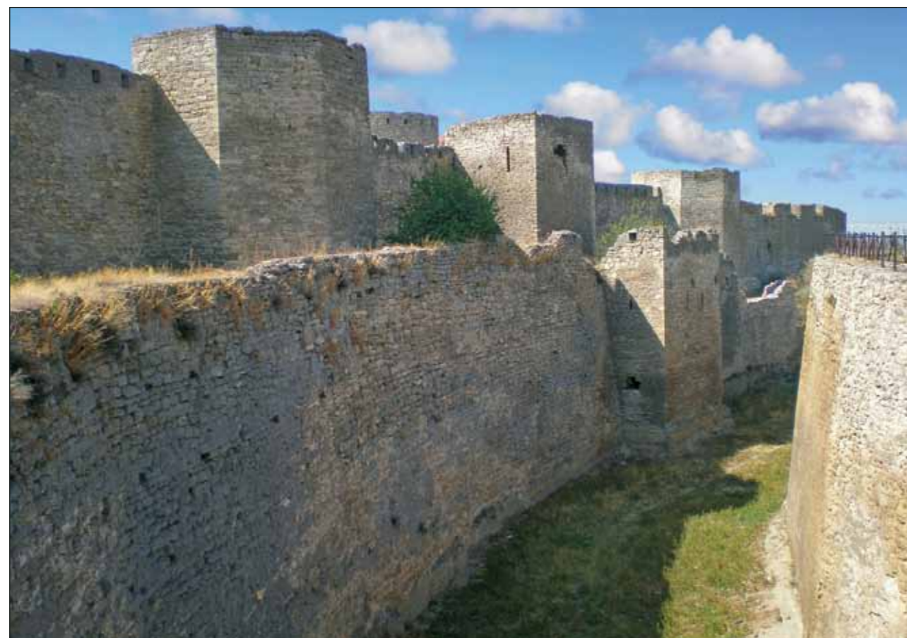
Белгород-Днестровская крепость. Вид со стороны рва
