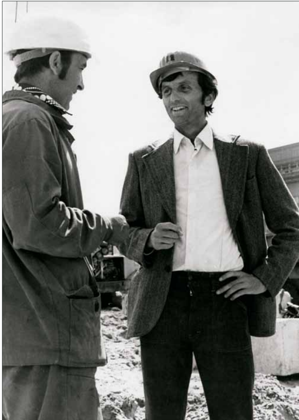
На строительстве Вьетнамской ГЭС. Середина 1980-х гг.
