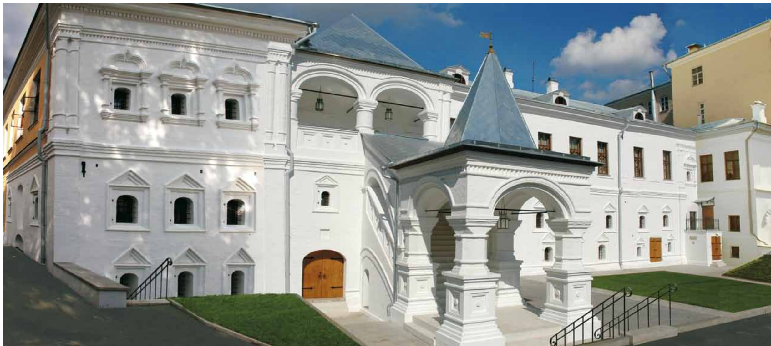
Панорама дворового фасада ▶ с воссозданным Красным крыльцом XVII века после реставрации. 2006
