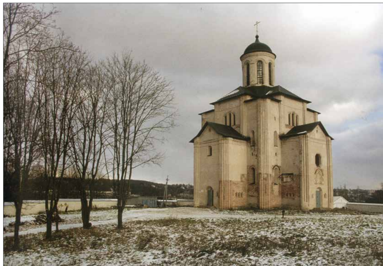
В церкви Михаила Архангела (кон. XII в., Смоленск) древние своды оштукатурили цементом. Фото А.С. Терёхина
